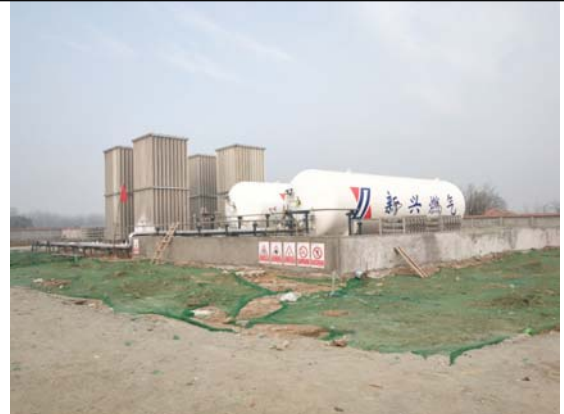
储罐、气化器
